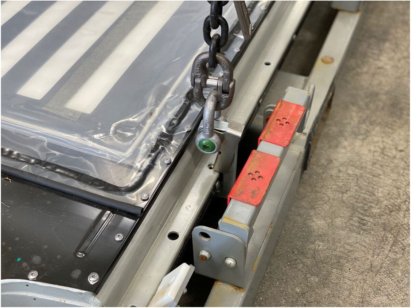
51. 古いHVバッテリーからガントリーとHフレームを引き上げる。
