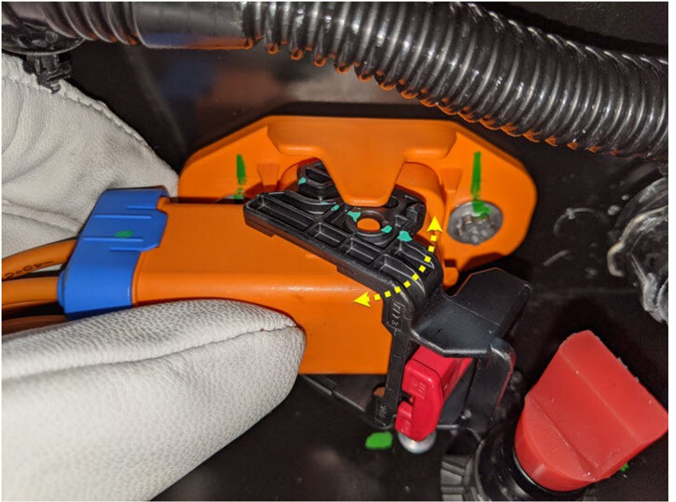
161. HVバッテリーをバッテリーテーブルから上げる。
