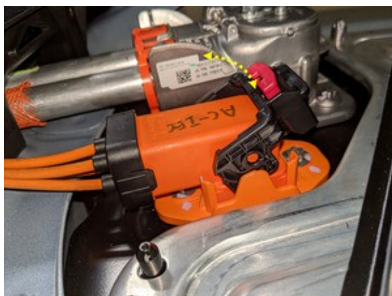
図2.3相HVバッテリーのAC充電インターフェース
